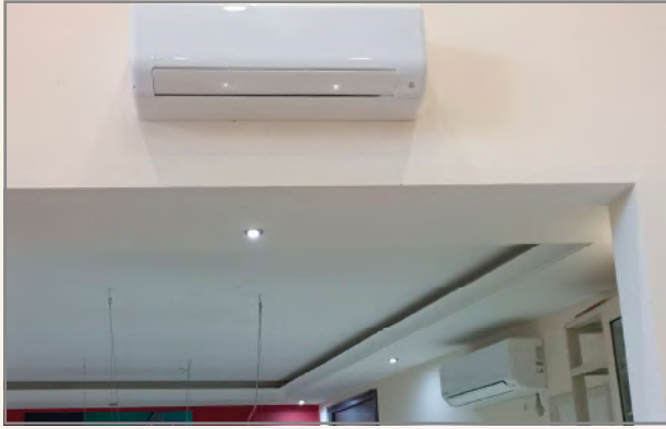
Wiehed mill-airconditioners li għe installat fiż-żona tal-bottegin.
