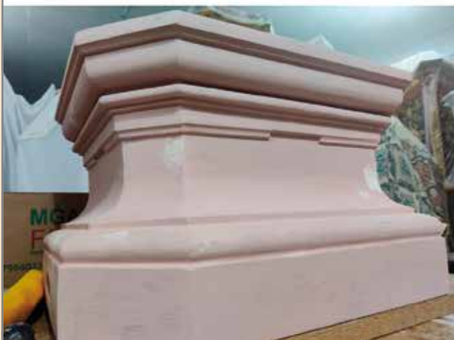
Partijiet mill-pedestalli tal-aṅgli li kellhom jiżżarmaw u l-fażi finali fejn inżebaħ bl-undercoat.
