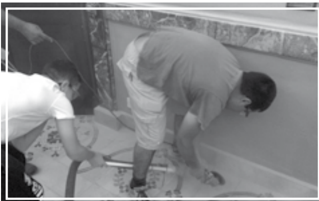
Glenn Zammit waqt xogħol ta' manutenzjoni fuq il-madum tas-sala
