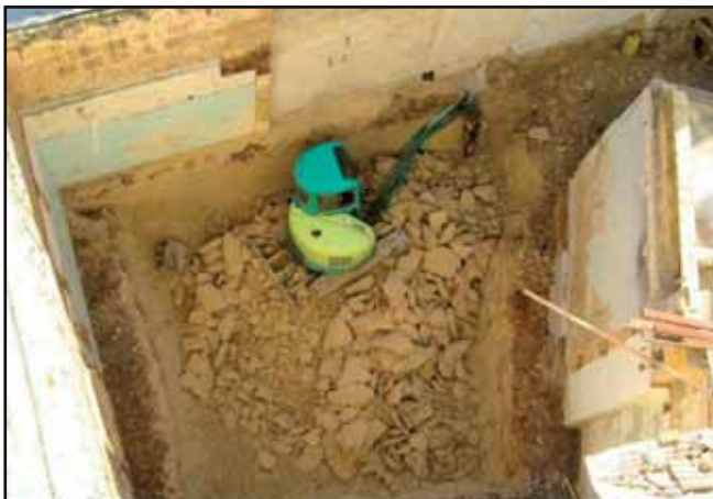
Wara li sar ix-xogħol tat-twaqqiegh, beda x-xogħol tal-iskavar. Fir-ritratt jidher it-thammil tas-sotterran li ser jintuża bħala workshop.
